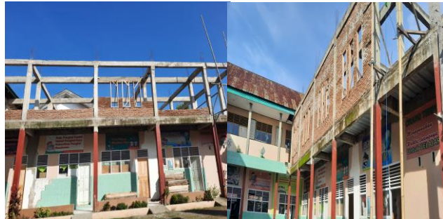
Gambar 4.6 Pembangunan Lantai II
