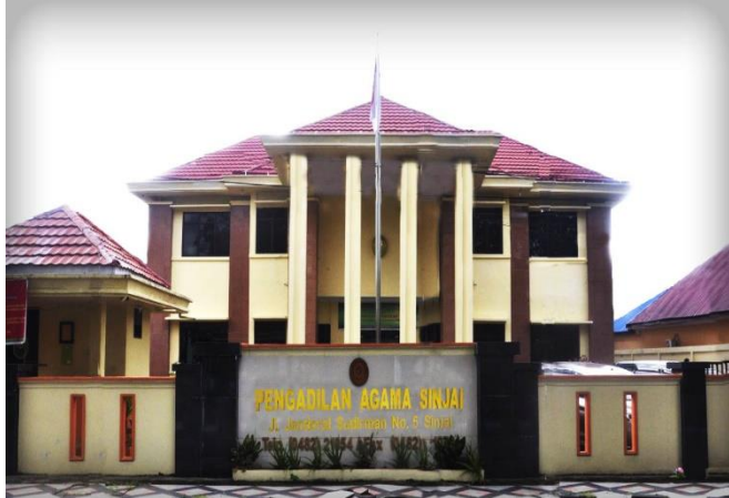
Gambar 3.1 Gedung Pengadilan Agama Sinjai Jl.Jenderal Sudirman No.5,Kab.Sinjai (Sumber: Dokumen Peneliti)
