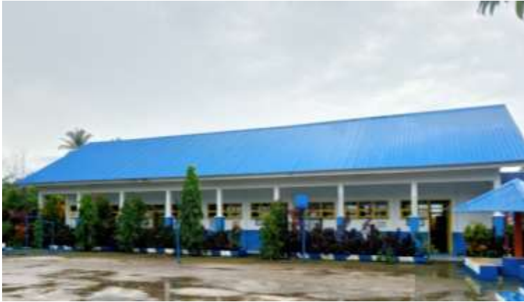
Dokumentasi 3 Kelas yang Telah di Renovasi
